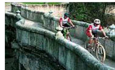
Puente de la culebra
